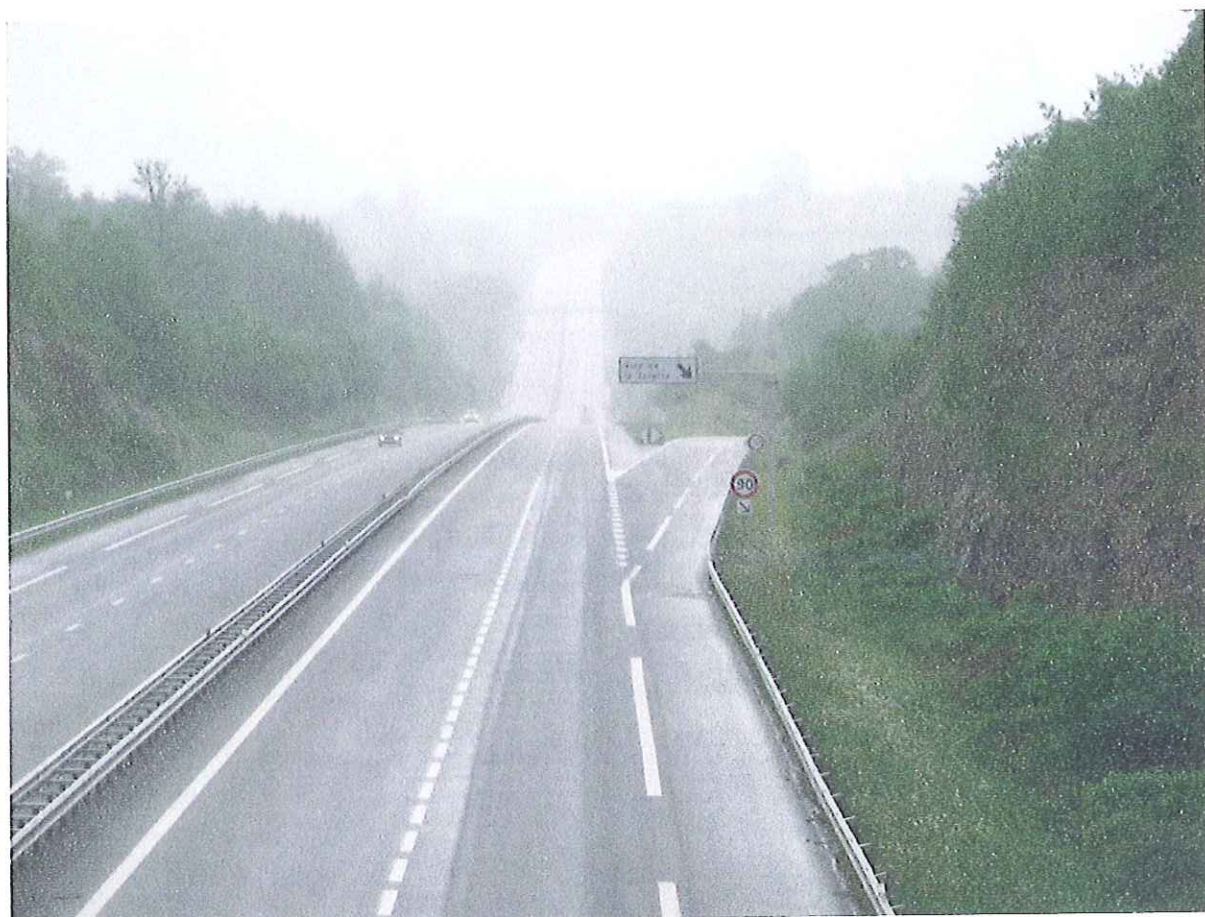
Figure 38 Vue depuis le pont de la RD 21 des 4 voies
