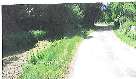
Figure 23 Vue du pont vers ENVEAUX
